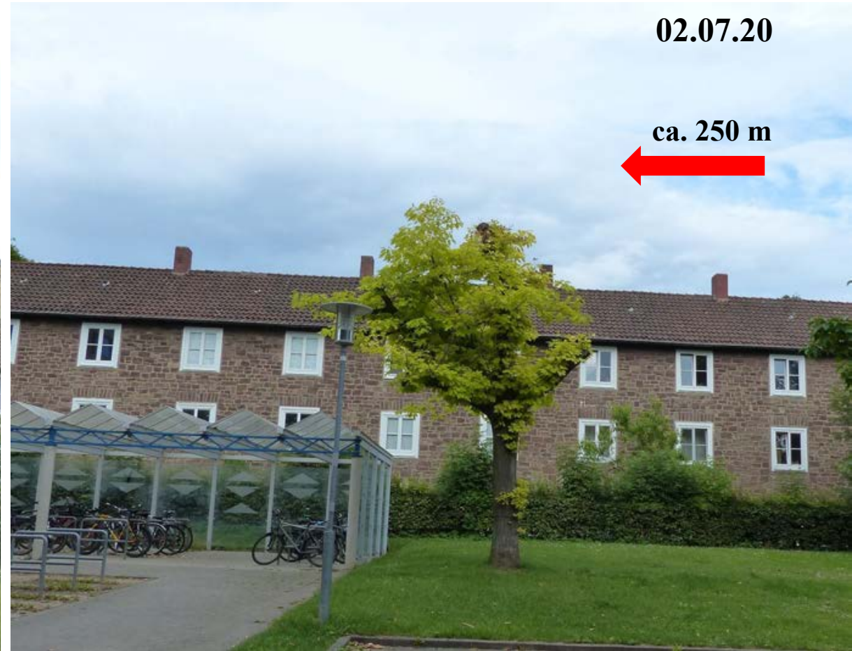
Drei 0^\circ -Antennen des Verfügungsgebäudes (27,5 m) treffen auf die Roteiche
