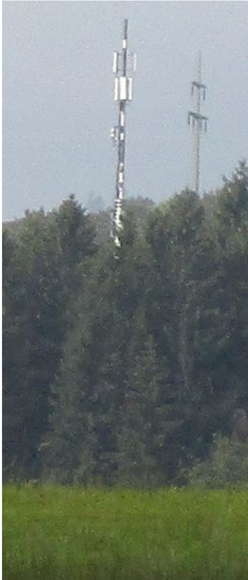
Mobilfunksender Rickenbach Blick von Süden, vom Waldrand
