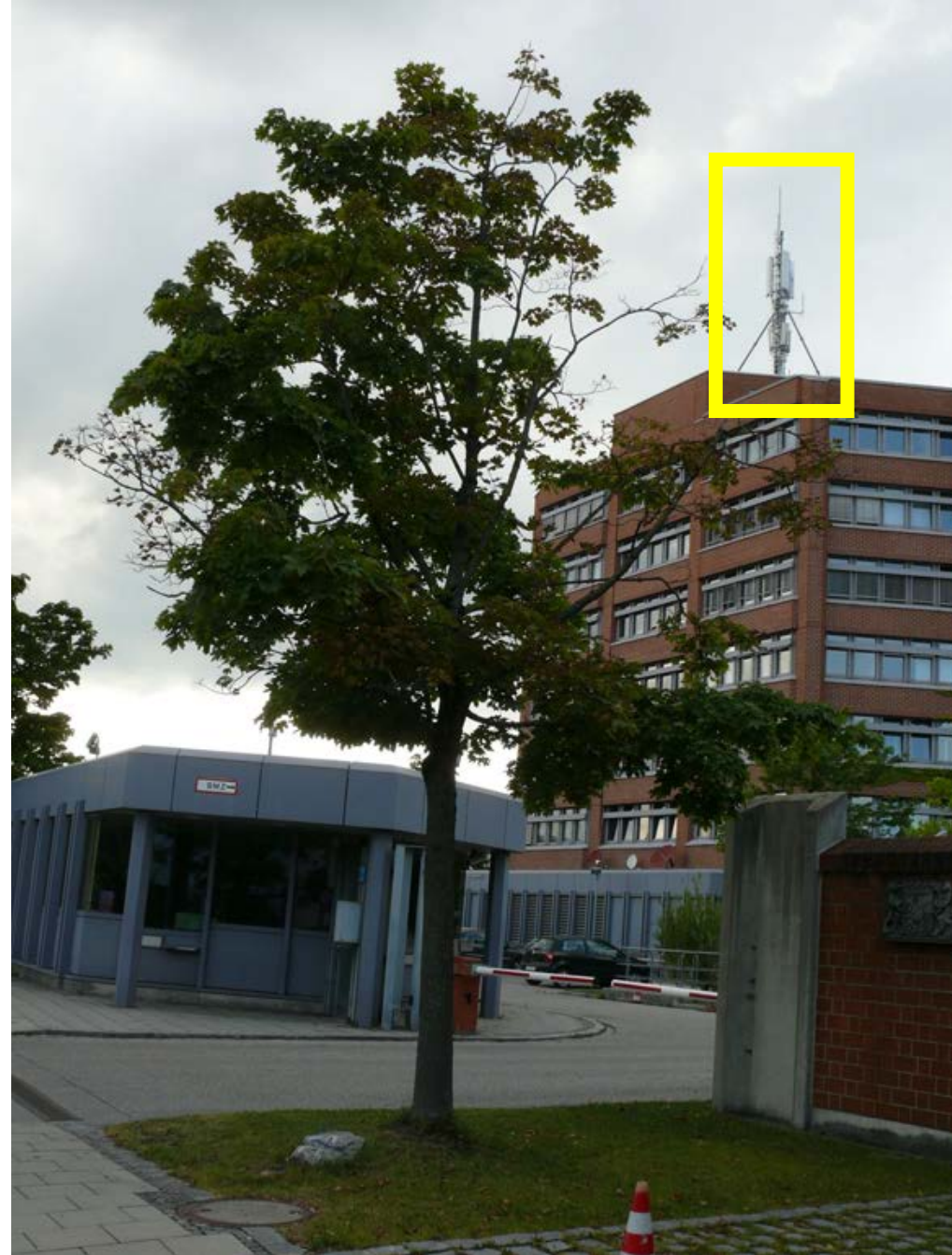
03.08.12 Pforte des Landesamt für Verfassungsschutz, Knorrstr. 139, Sendeanlage 1
