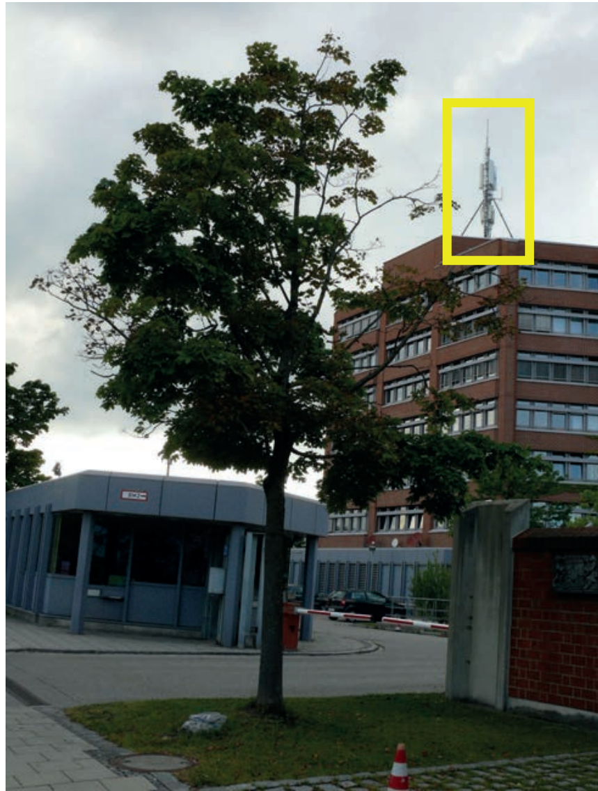
03.08.12 Pforte des Landesamt für Verfassungsschutz, Knorrstr. 139, Sendeanlage 1
