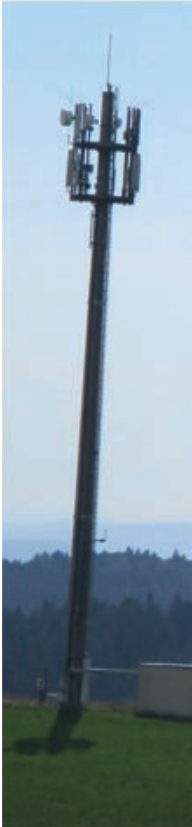
Mobilfunksender mit 37 Sektorantennen und TETRA
