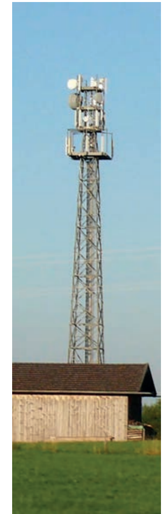
Sendemast Seehausen (686 m ü. NN) Höhe 36,1- 43,8 m, 36 Antennen (2020)
